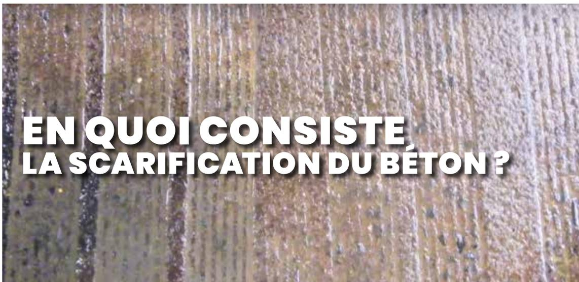
**Contrairement au rainurage, la scarification se caractérise par un rabotage de l'ensemble de la surface bétonnée.**
