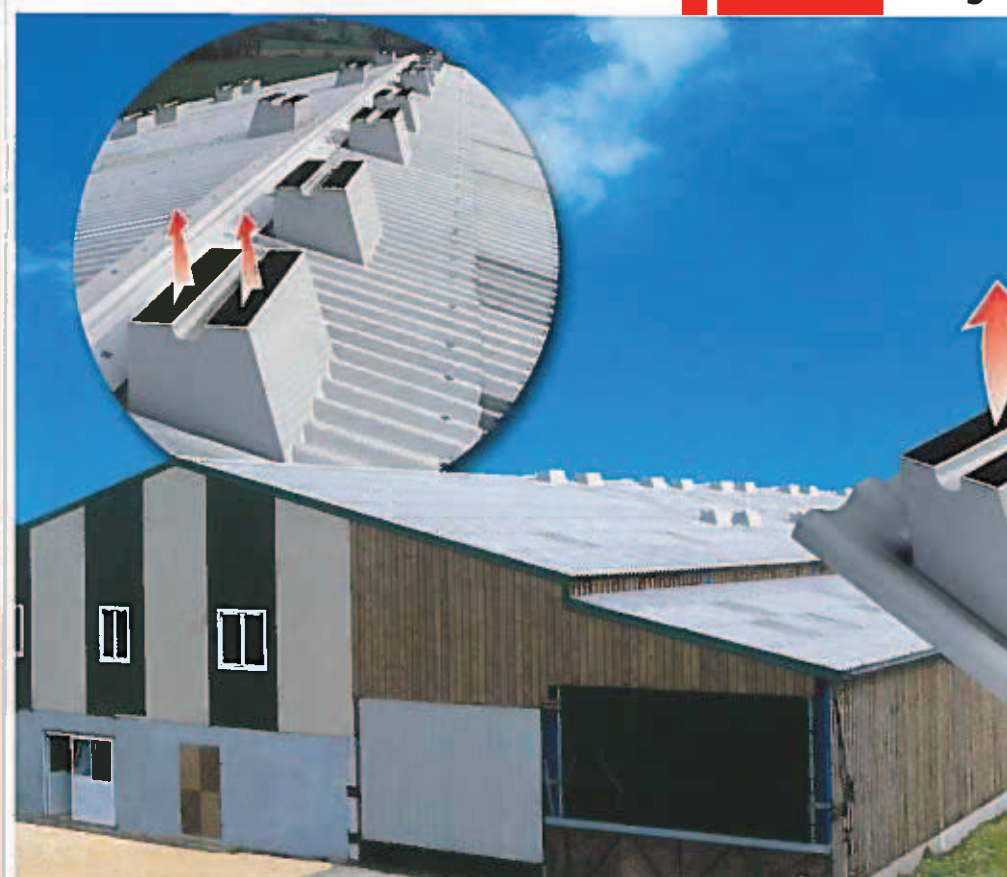
Bâtiment de 24 m x 42 m – 65 vaches laitières sur 3 rangées de logettes
