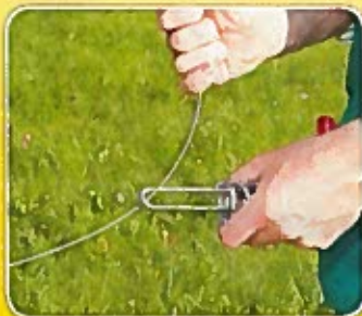
Passez le fil dans la boucle du ressort
