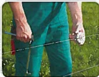
Placez le tendeur et fixez la clé
