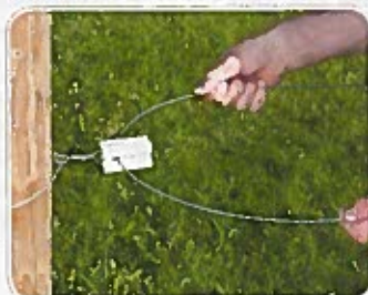
6. Faites passer le fil dans l'isolateur en tirant bien dessus
