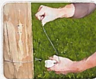
3. Introduisez le bout du fil dans les trous de l'isolateur
